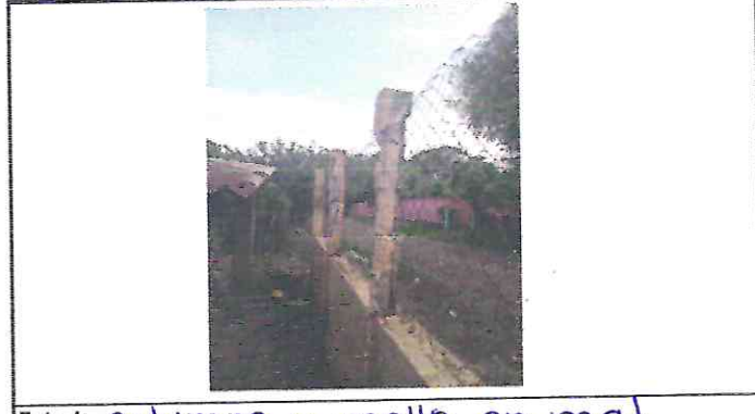
Foto 4: Columna y malla en mal estado de muro Perimetral
